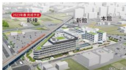
2023 年春より稼働の新棟
